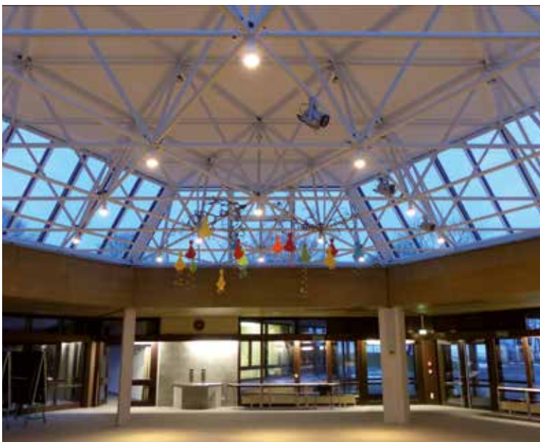
Energetisch sanierte Kuppel der Alten Aula mit Beschattung. Acht weitere Glaskuppeln des Altbaus wurden ebenfalls saniert und beschattet.
