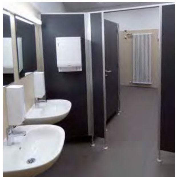
Erneuerung der Toilettenanlagen im Altbau (Alte Aula) mit separater Behindertentoilette
